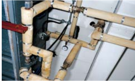
Asbestos pipe lagging
